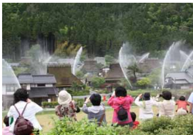
美山かやぶきの里 放水銃一斉点検
