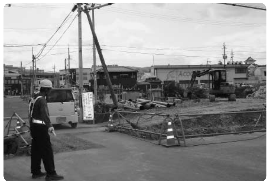
工事が進む園部中心市街地
