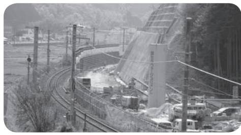
JR 複線化工事(園部町内)
