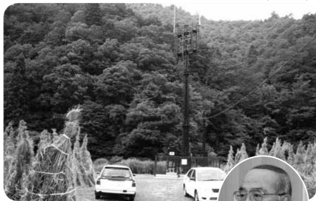
移動通信用鉄塔（知見局）
