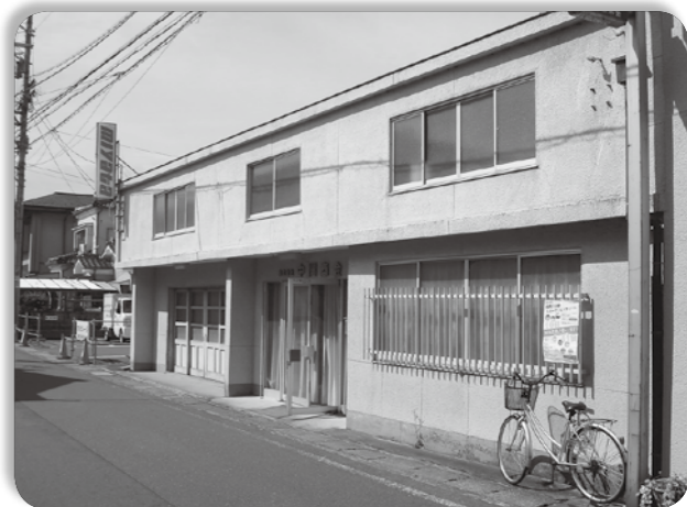
地活センターの設置が計画されている街中の民家
