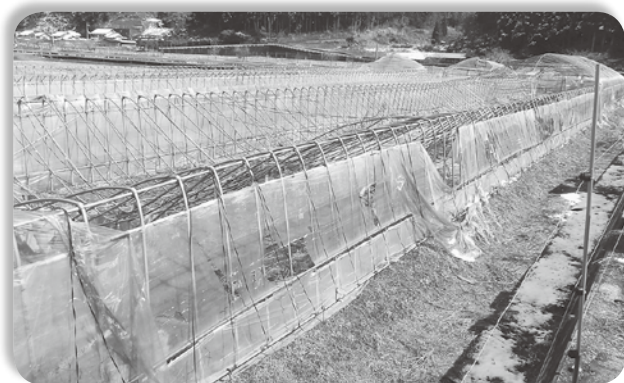
雪で倒壊したパイプハウス
