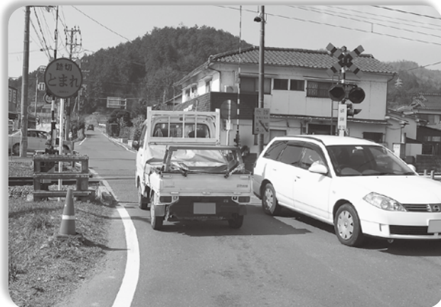
拡幅が待たれる胡麻路切付近
