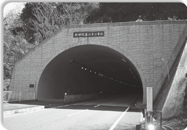
非常用設備の設置が待たれる新世紀第二トンネル
