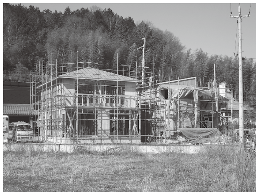
建築がすすむ住宅（園部町内林地内）
