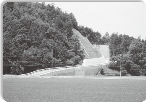
改良が進む市道室橋高畑線
