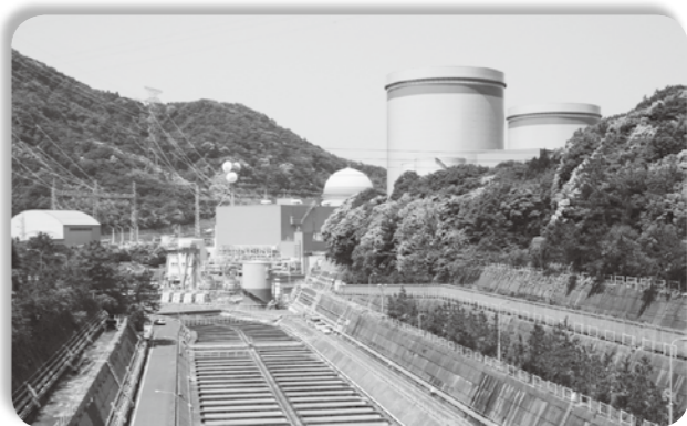
高浜原子力発電所
