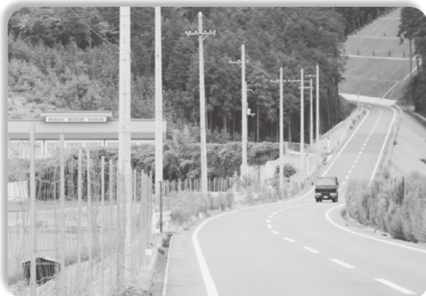
八木町水所・神吉間の新設道路
