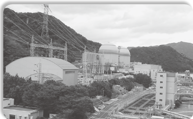
高浜原子力発電所
