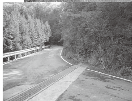
舗装された箇所
