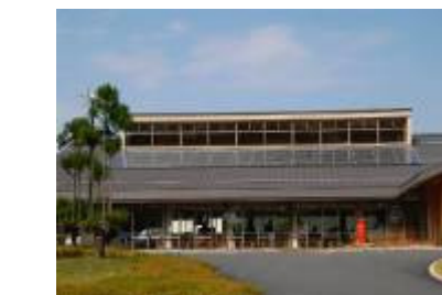
美山支所の太陽光発電設備
