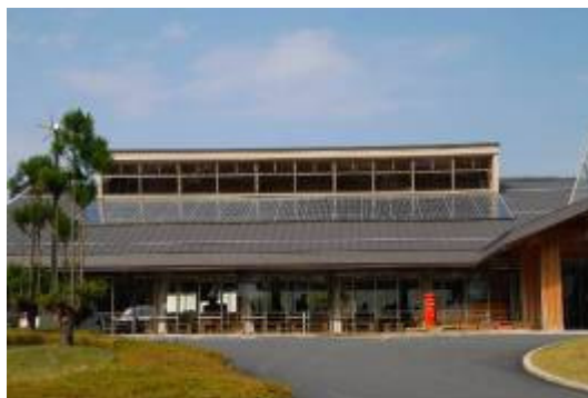
美山支所の太陽光発電設備
