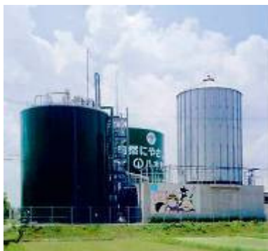
八木バイオエコロジーセンター
