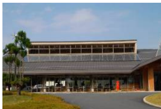
美山支所の太陽光発電設備
