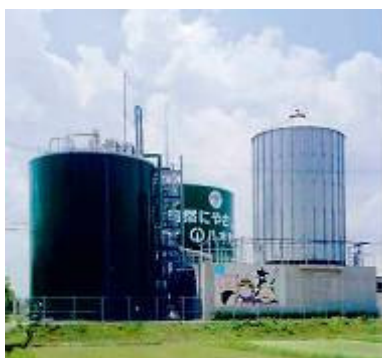
八木バイオエコロジーセンター
