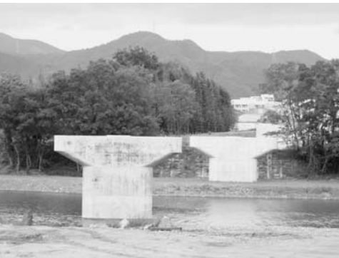
完成した第二大堰橋の下部工事
