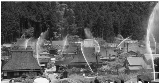
62基の放水銃から一斉に放水されました
