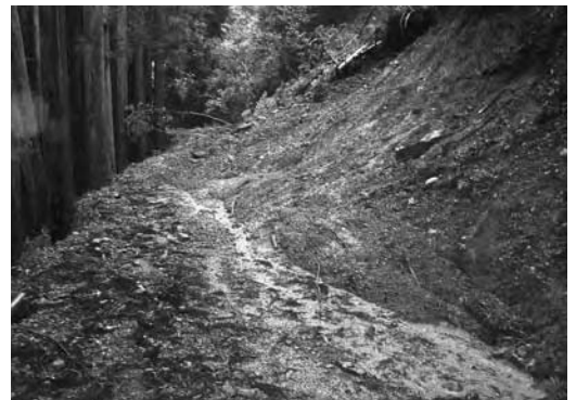
通行不能になった林道（園部町熊崎）
