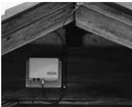
▲軒先に引き込まれた光ファイバーケーブル
