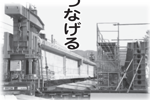
▲八木町地内でのJR複線化工事
