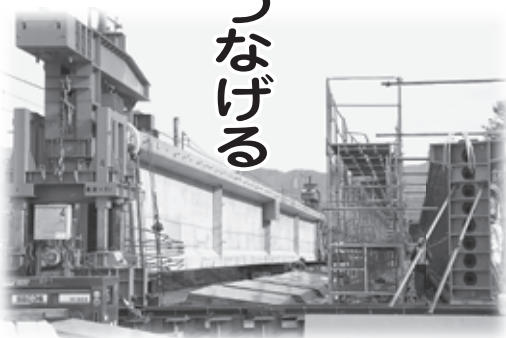
▲八木町地内でのJR複線化工事
