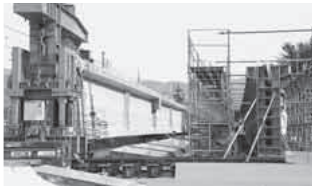
▲八木町地内でのJR複線化工事
