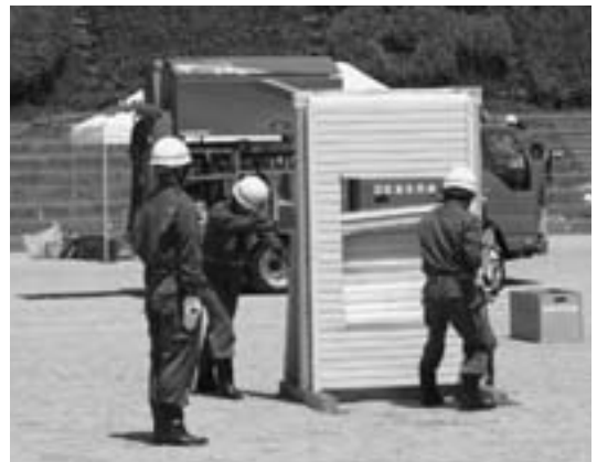
▲エンジンカッターでシャッターを切断する団員
