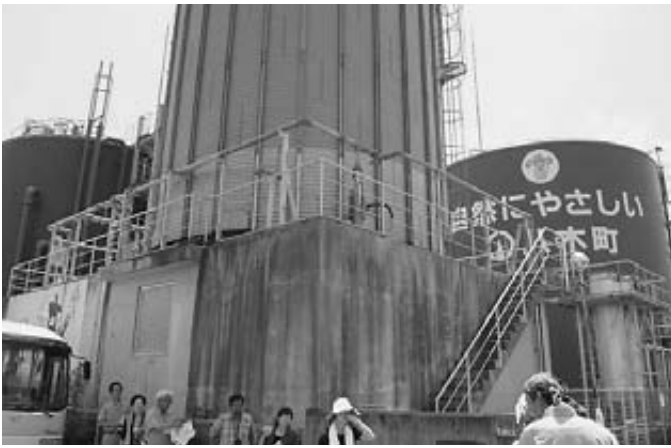
▶メタン発酵処理で資源を循環させます (八木バイオエコロジーセンター)
