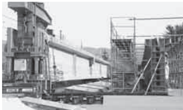
▲八木町地内でのJR複線化工事
