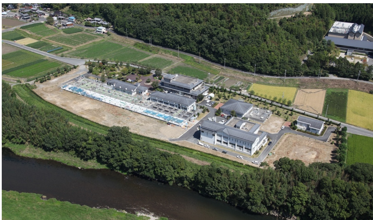
公共下水道の処理場である南丹浄化センター
