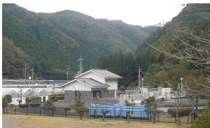
日吉町殿田浄化センター
