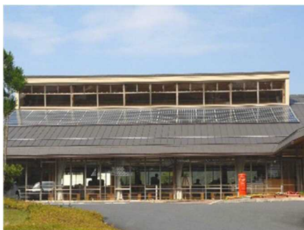
美山支所に設置されている太陽光発電
