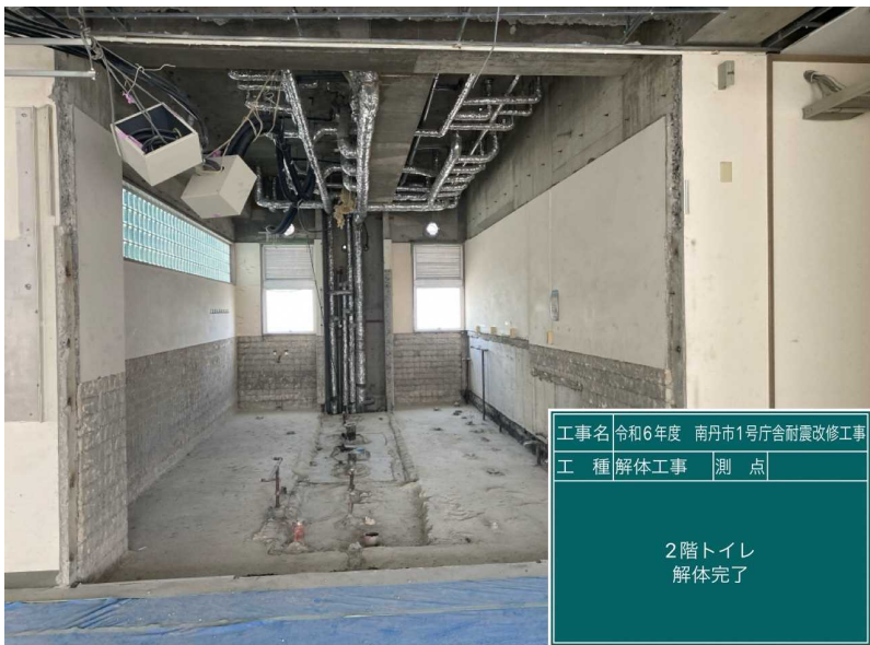
2 階トイレ部分 解体完了
