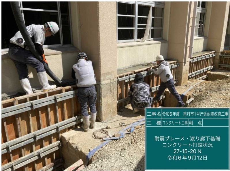
耐震ブレース コンクリート打設状況
