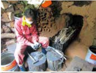
▲経験者の指導のもと、窯打ち作業を行い、頑丈な窯に仕上げる。(美山窯)
