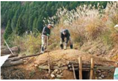
▲経験者の指導のもと、窯打ち作業を行い、頑丈な窯に仕上げる。(美山窯)
