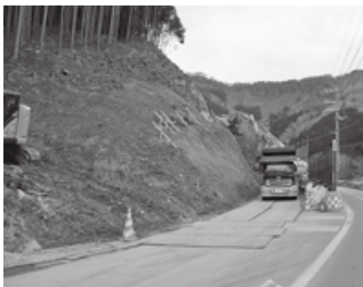
▲工事が進む府道19号園部平屋線
