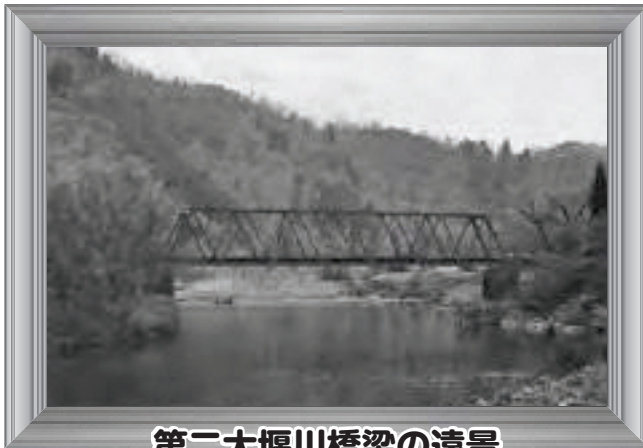
第二大堰川橋梁の遠景
