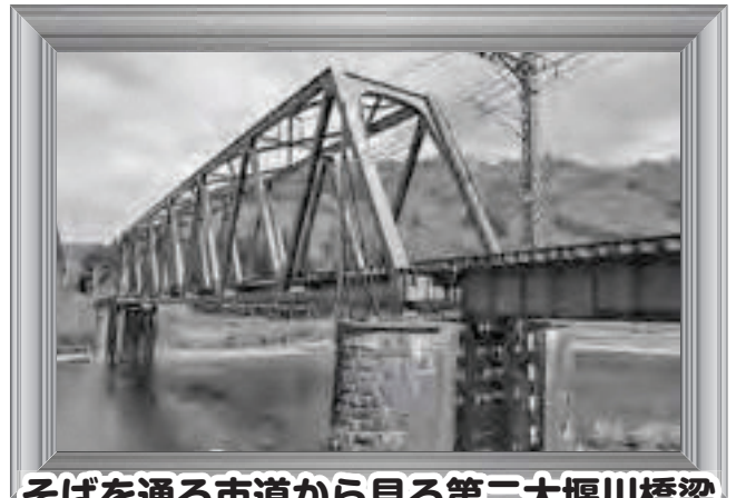
そばを通る市道から見る第二大堰川橋梁
