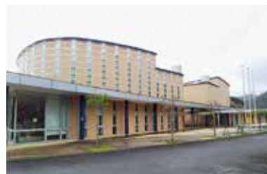
財政健全化プランの中の積み残した大型事業の一つ日吉生涯学習センター改修事業
