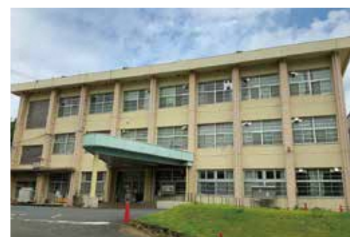
耐震改修工事が実施される本庁1号庁舎
