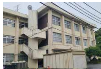
耐震改修工事を行う本庁1号庁舎
