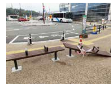
壊されてそのままになっているベンチ 早急の復旧が求められる
