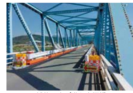
補修工事が進む大堰橋
