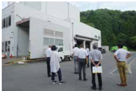
老朽化が進んでいる京都中部クリーンセンター
