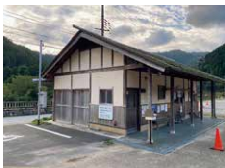
管理者が変更された、かやぶきの里公衆トイレ
