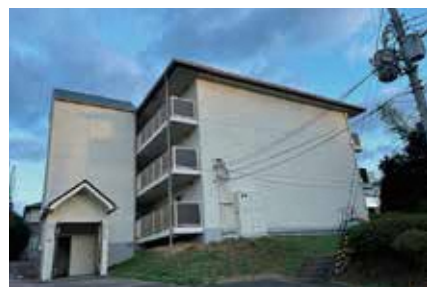
改修された市営小桜団地
