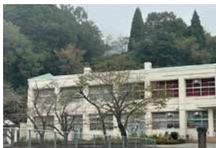
改修された殿田中学校
