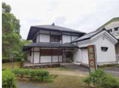
改修が予定される女性の館
