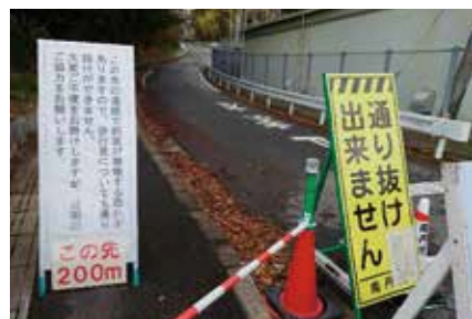
復旧予定の市道
