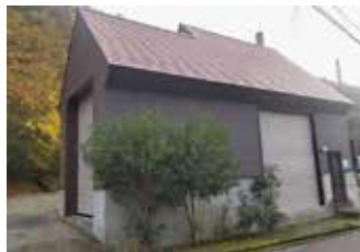
木質バイオマスボイラー施設 (美山町・河鹿荘)
