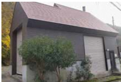
スプリングスひよしに導入が計画されている木質系バイオマスボイラー (写真は美山の河鹿荘のボイラー)
