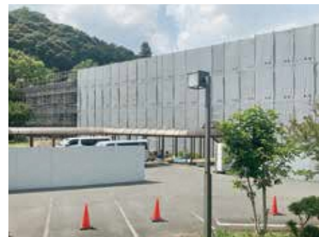
耐震改修工事が進む2号庁舎
