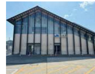
JR八木駅東口の状況
