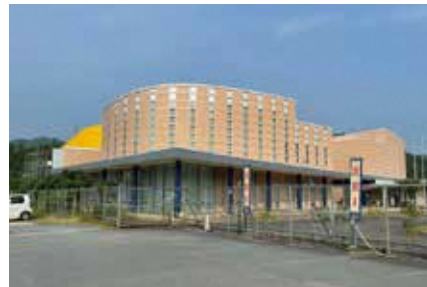
工事が進む日吉生涯学習センター (遊youひよし)
