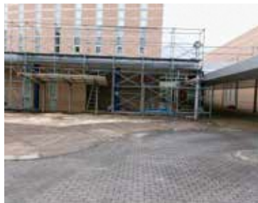
改修中の南丹市日吉生涯学習センター
