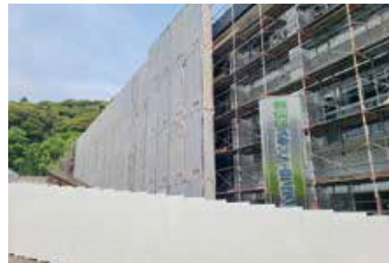
2号庁舎耐震改修工事のようす
