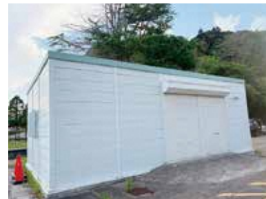
備蓄品が備えられている防災倉庫
