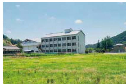
学校給食共同調理場の建設予定地
