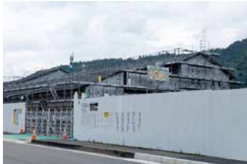
建設中の学校給食共同調理場
