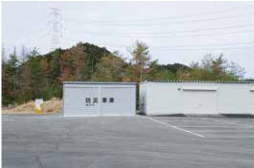
防災備蓄倉庫建設予定地
