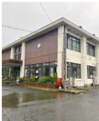
地域の振興会が管理している旧小学校施設
