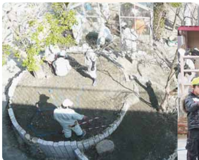
老人福祉施設での庭園整備 実際に使われている施設を整備することで視野も広がる
