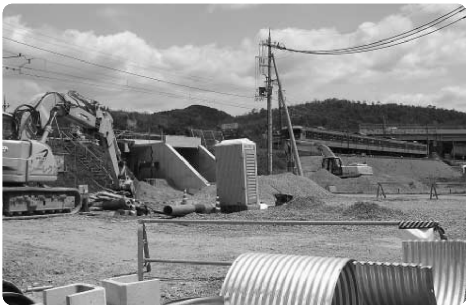
平成20年度完成予定の山陰本線複線化工事
