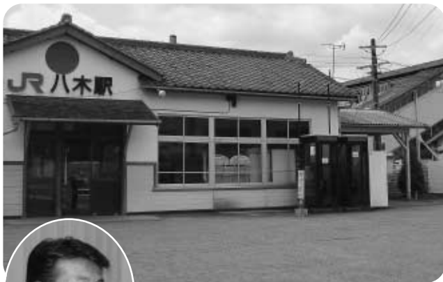
老朽化が著しい八木駅舎と高架橋
