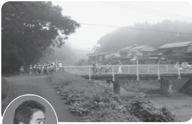
老朽化した住吉橋（三俣川）
