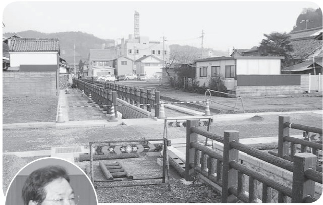
整備が進む市街地再開発事業
