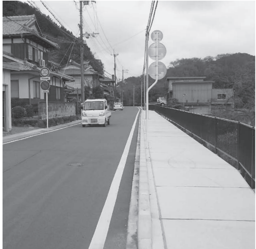
府道吉富八木線の歩道新設
