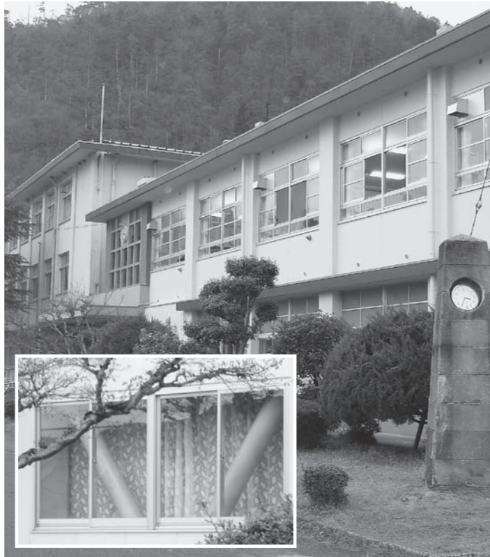
美山中学校の耐震補強
