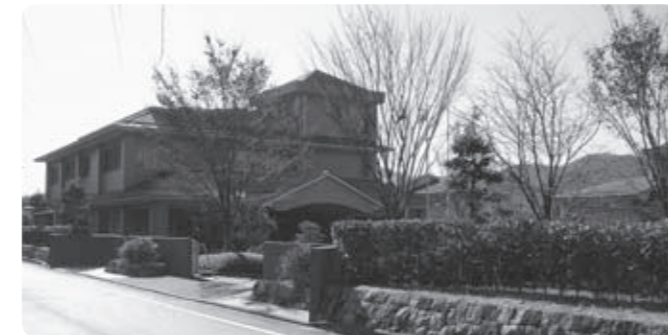
桂川中流流域下水道南丹浄化センター（八木町）
