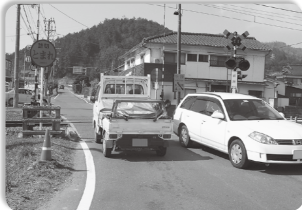
拡幅が待たれる胡麻路切付近
