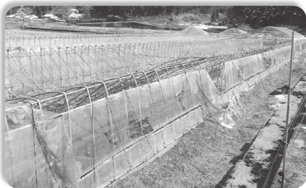
雪で倒壊したパイプハウス
