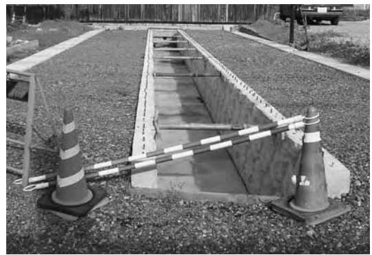
工事中の歩行専用道路
