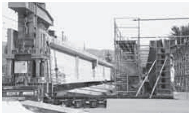
▲八木町地内でのJR複線化工事
