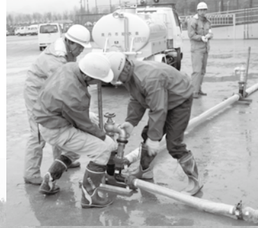
▲断水に伴う仮設給水設備の設置
