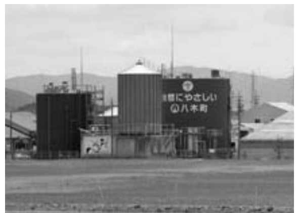
▲緑のタンクが目印のバイオエコロジーセンター
