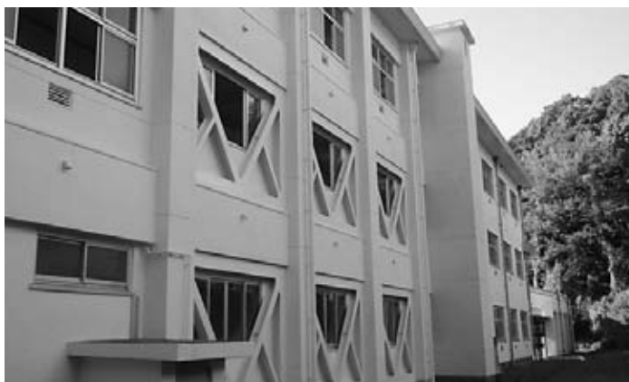
▲耐震化工事を終えた殿田中学校
